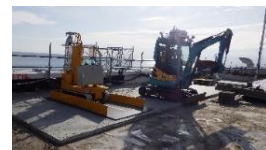
充電ベース床面コンクリート遮蔽
