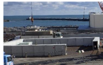
3T/B 海側ヤードコンテナ仮置場の遮蔽
