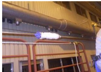
養生チューブ設置イメージ
