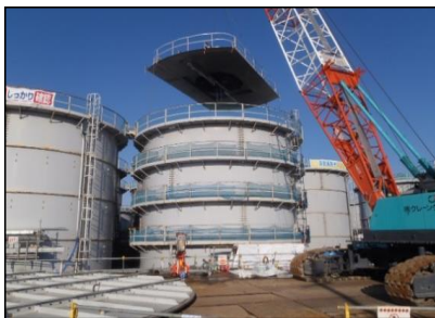
吹付装置の据付
