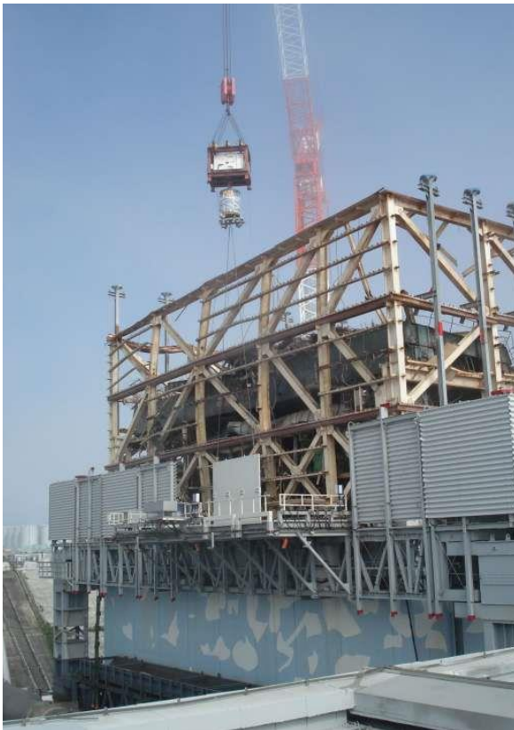
南作業床吊り遮へい状況
