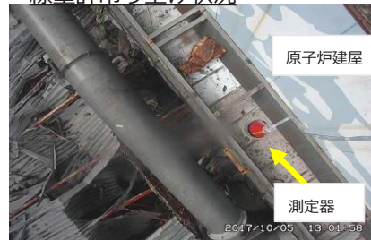
線量率測定状況 (サテライトカメラから撮影)
