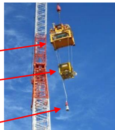
線量計吊り上げ状況
