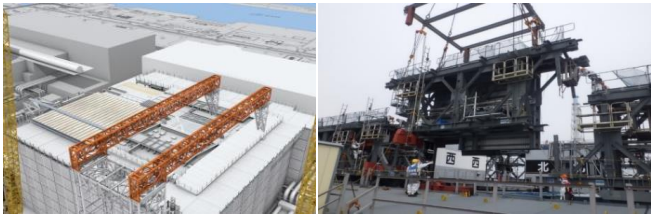
メイントラスの大型ユニット化
