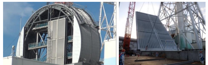
妻壁の先行組立・大型ユニット化
